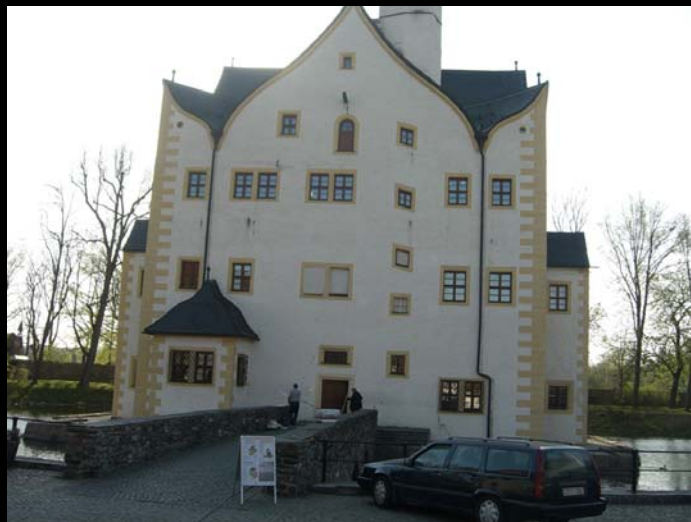
Castel Klaffenbach, Chemnitz, 2007
